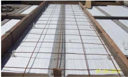
Figura 13 a) V11 y bovedilla de poliestireno
