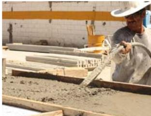
Figura 14 c) Colado de la losa
