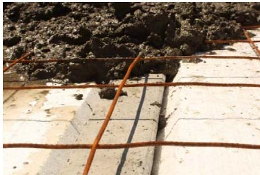
**Figura 4 Colado de firme de compresión sobre vigüeta**
